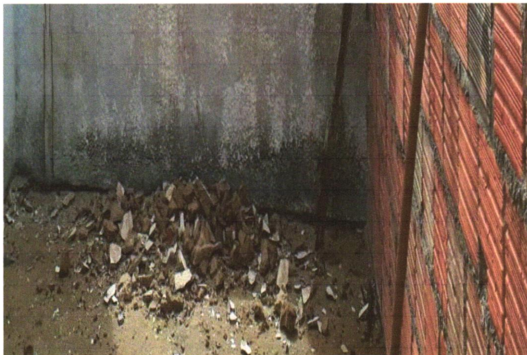
FOTO 13 – Demolição de reboco
