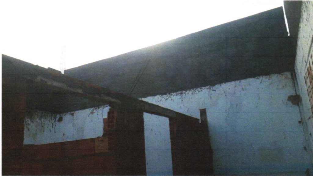
FOTO 11 – MASSA ÚNICA, PARA RECEBIMENTO DE PINTURA OU CERÂMICA, ARGAMASSA INDUSTRIALIZADA, PREPARO MECÂNICO, APLICADO COM EQUIPAMENTO DE MISTURA E PROJEÇÃO DE 1,5 M 3 /H EM FACES INTERNAS DE PAREDES, ESPESSURA DE 5MM, SEM EXECUÇÃO DE TALISCAS. AF_06/2014
