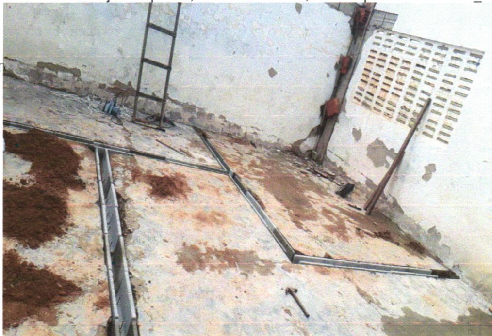
FOTO 16 Bloco cerâmico tipo "u" (calha) 9x19x19cm
