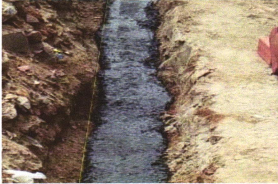
Foto 17 - LASTRO DE CONCRETO MAGRO, APLICADO EM BLOCOS DE COROAMENTO OU SAPATAS, ESPESSURA DE 3 CM. AF_08/2017
