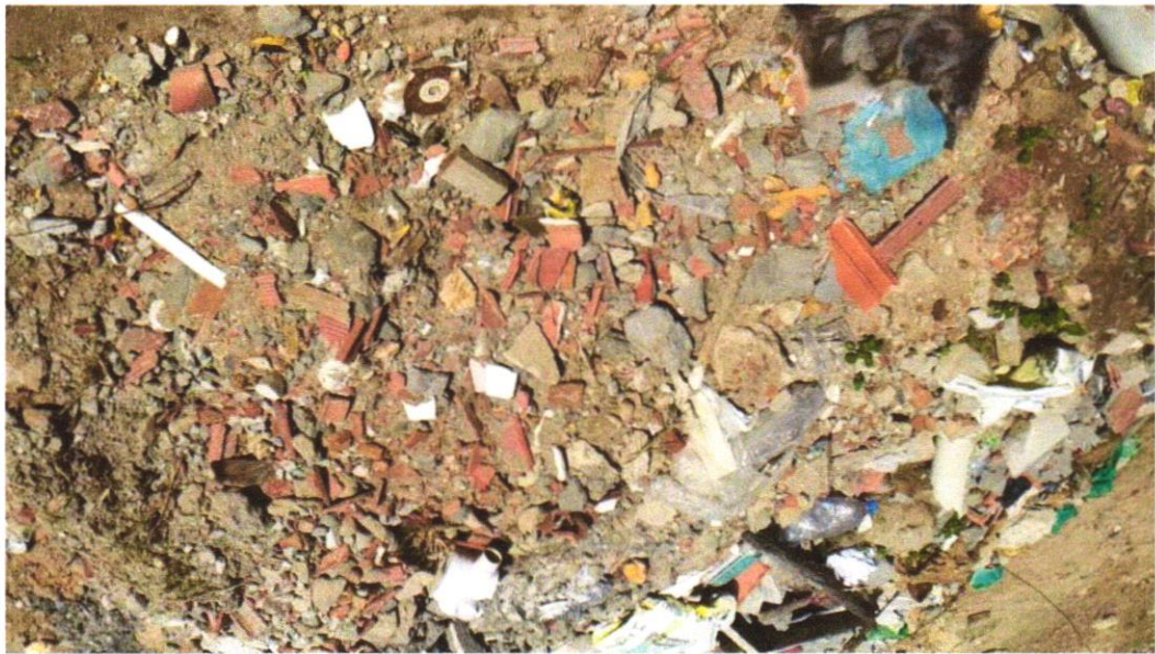
FOTO 03 - Demolição de alvenaria de bloco cerâmico e=0,09m - revestida
